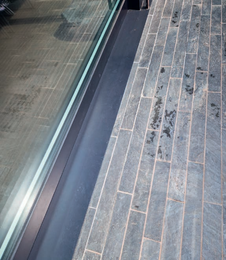
Türen und Fenstertüren zu Terrassen, Balkonen und Aussensitzplätzen sollten rollstuhlgerecht, das heisst grundsätzlich ohne Schwellen erstellt sein. Foto: Felix Käppeli
