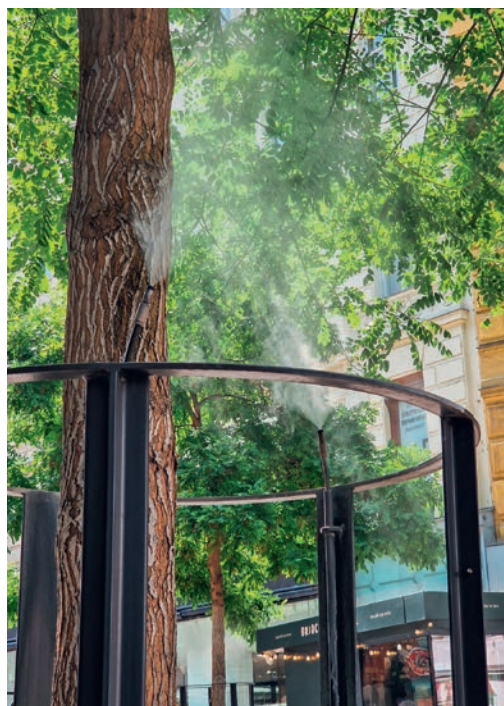
In Wien dienen die Nebelstelen in den Pflanzflächen der Abkühlung des Stadtklimas durch feinen Hochdruck-Wasserdampf. Der Wasserdampf kühlt die umliegende Luft in der stark belasteten Innenstadt um mehrere Grad, was Hitzeinseln entgegenwirkt. Die Anlagen schalten sich automatisch bei Temperaturen über 20 bis 30 Grad ein, oft mit Temperatursensoren, und stoppen, sobald es kühler wird. Sie verbrauchen wenig Wasser und Energie.
