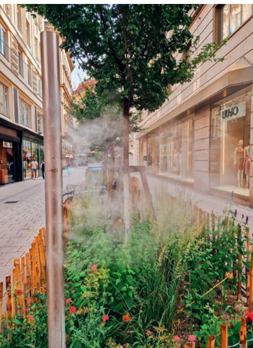
In Wien dienen die Nebelstelen in den Pflanzflächen der Abkühlung des Stadtklimas durch feinen Hochdruck-Wasserdampf. Der Wasserdampf kühlt die umliegende Luft in der stark belasteten Innenstadt um mehrere Grad, was Hitzeinseln entgegenwirkt. Die Anlagen schalten sich automatisch bei Temperaturen über 20 bis 30 Grad ein, oft mit Temperatursensoren, und stoppen, sobald es kühler wird. Sie verbrauchen wenig Wasser und Energie.
